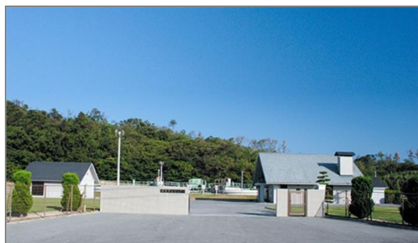
姫島浄化センター
